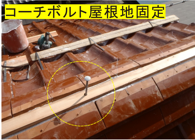
コーチボルト屋根地固定
